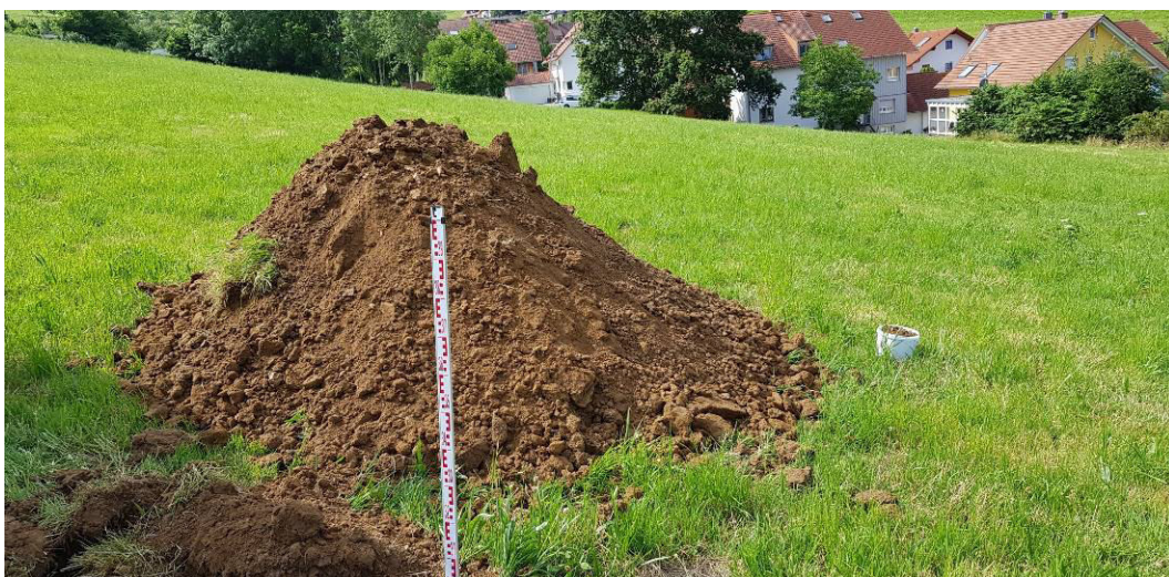
Abb. 5: Schurf SCH5/19, Aushub seitlich gelagert
