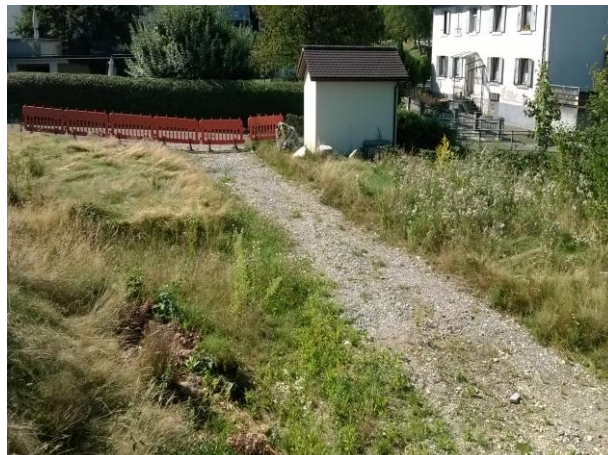
Abbildung 6: Trafohäuschen im südwestlichen Bereich, rechts der Gewässerrandstreifen.
